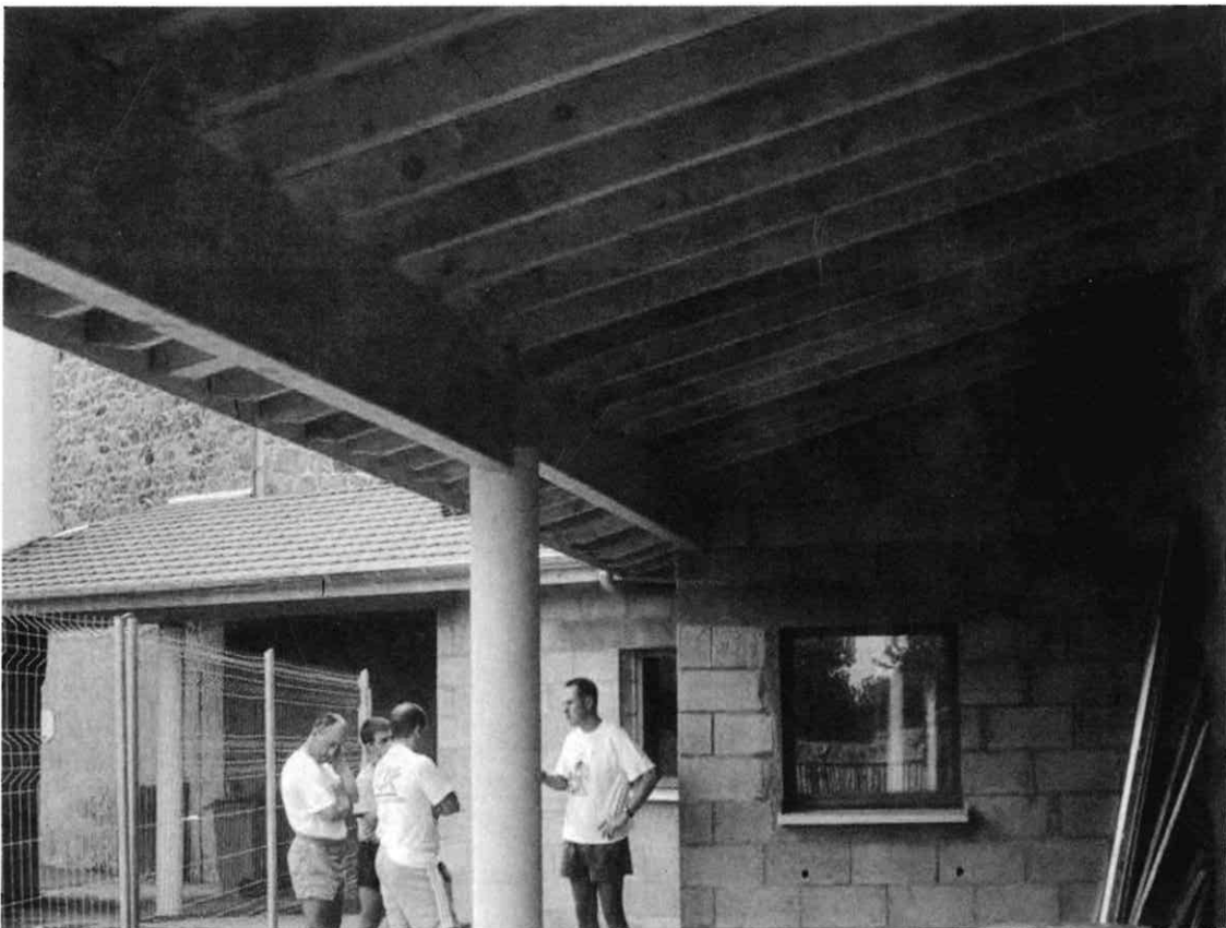
Travaux en cours
